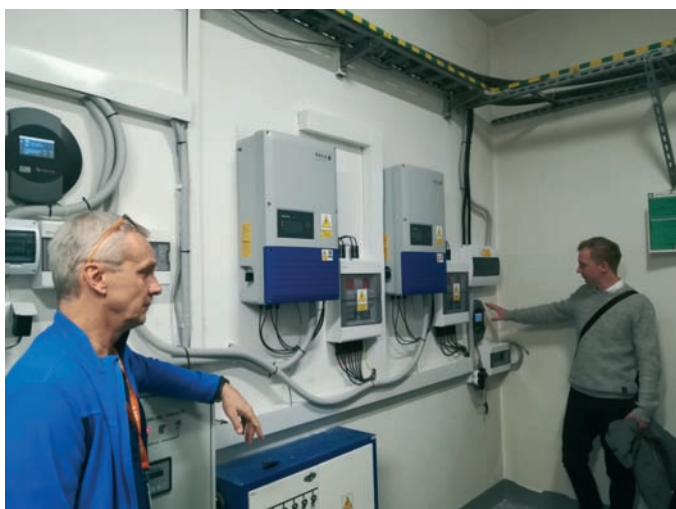
Sterowanie ogniwami fotowoltaicznymi – Pływalnia Miejska Podolanka w Płocku
