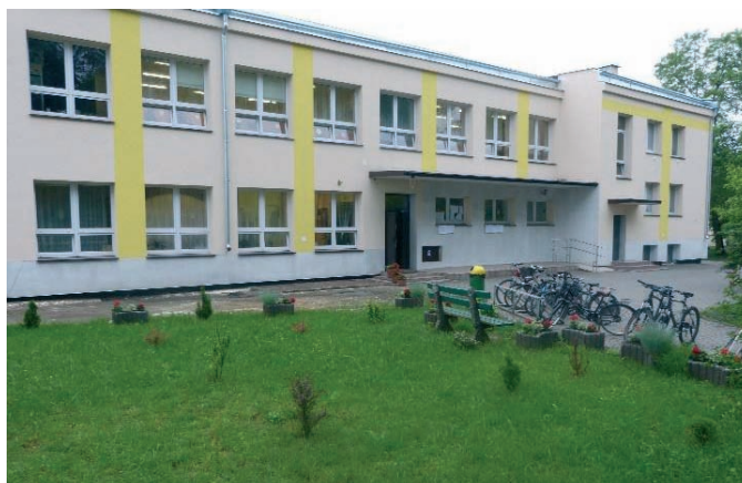
Fot. Obiekt Szkoły Podstawowej w Dębem Wielkim: Stan po termomodernizacji
