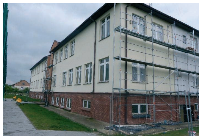
Fot. Obiekt Szkoły Podstawowej w Cygance: Prace termomodernizacyjne
