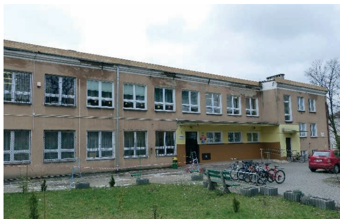
Fot. Obiekt Szkoły Podstawowej w Dębem Wielkim: Stan przed termomodernizacją
