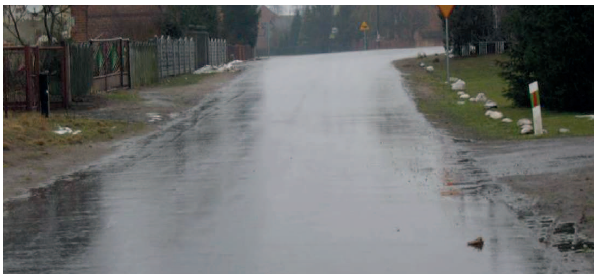
Budowa drogi nr 3245P Biała – Królików Powiat Koniński
