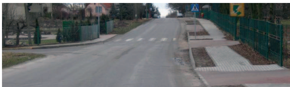
Budowa chodnika przy drodze nr 3209P w m. Wąsosze Powiat Koniński
