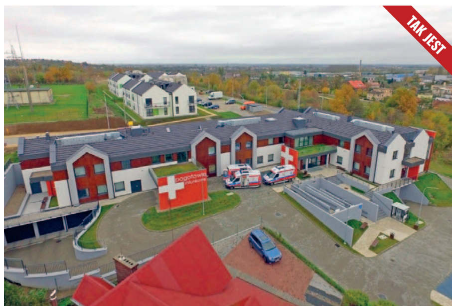
Budowa siedziby Samodzielnego Publicznego Pogotowia Ratunkowego w Pruszczu Gdańskim
