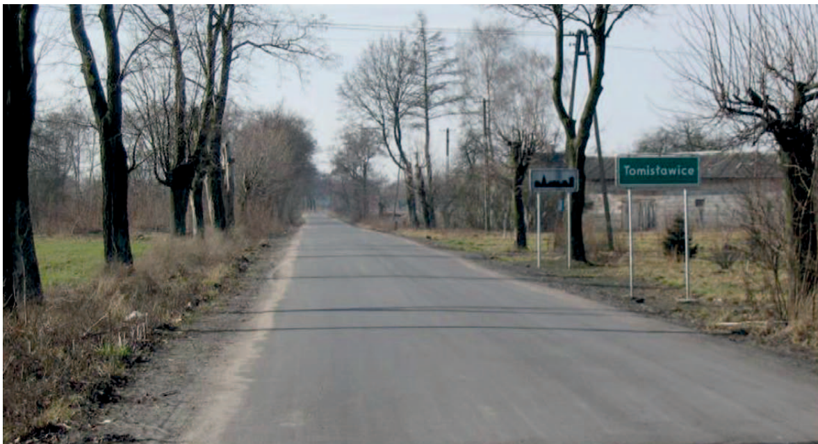
Ułożenie nawierzchni na drodze nr 3195P Tomistawice – Tomaszewo Powiat Koniński
