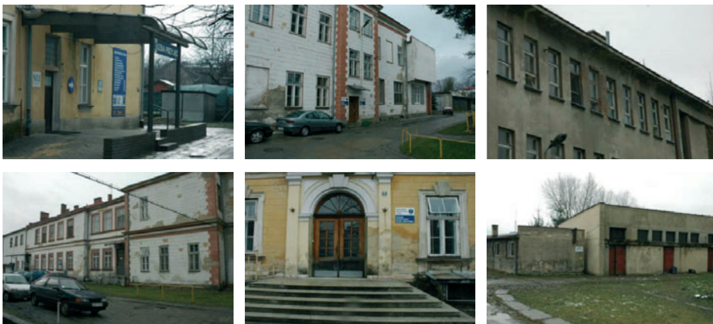
Szpital Powiatowy w Żywcu. 1. Wejście i podjazd na Izbę Przyjęć. 2. Wejście na Oddział ginekologiczno-położniczy. 3. Budynek Oddziału Wewnętrznego. 4. Widok na najstarszy budynek szpitalny z 1881r. 5. Wejście dla pogotowia ratunkowego na Oddział Intensywnej Terapii 6. Budynki techniczne (magazyn brudnej bielizny i magazyn odpadów medycznych).
