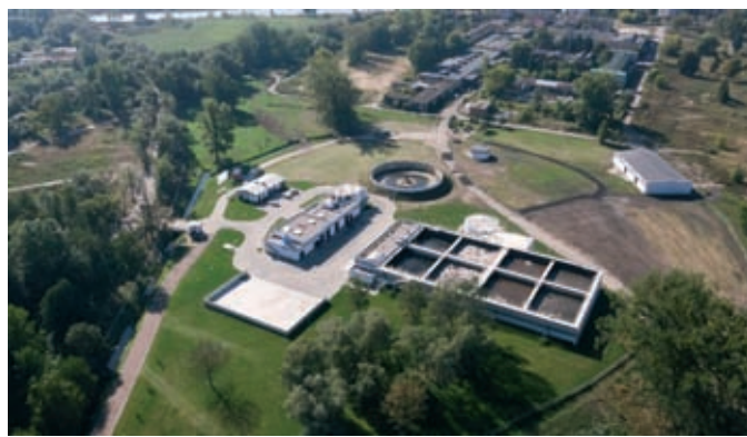
Oczyszczalnia po modernizacji
