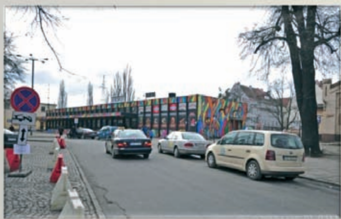
Ulica Dworcowa przed przebudową
