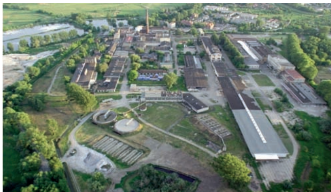
Oczyszczalnia przed modernizacją
