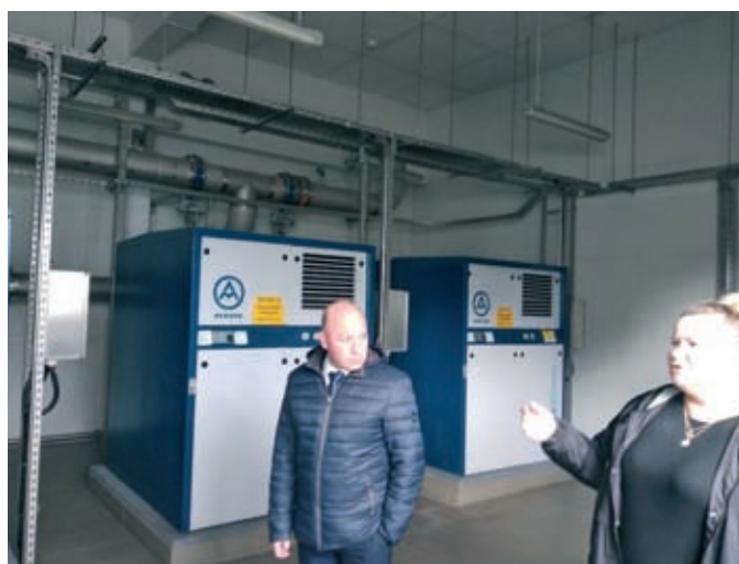
Napowietrzanie ścieków – agregaty w specjalnie wygłuszonej przestrzeni hali
