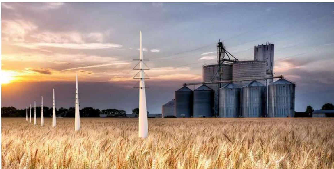
Rys. 4.7. Łopaty wiatrowe jako słupy energetyczne 481
