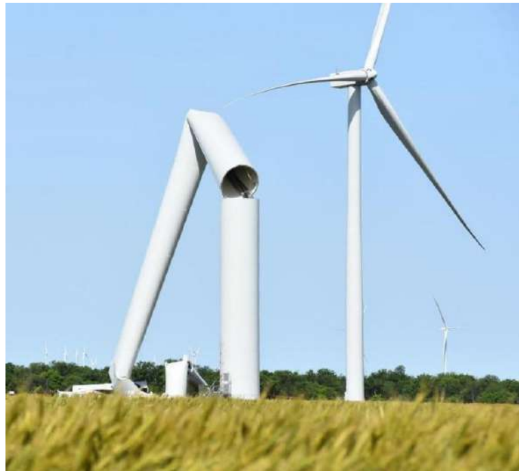
Rys. 1.33. Katastrofa konstrukcji wieży turbiny wiatrowej – materiały PSEW.
